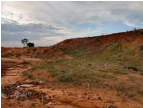
Fotos 07 e 08: Erosão em aterro executado e sob viga do gradil, causando dano ambiental
