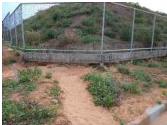
Fotos 07 e 08: Erosão em aterro executado e sob viga do gradil, causando dano ambiental
