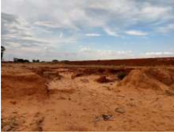
Fotos 05 e 06: Erosão em aterro executado, causando dano ambiental
